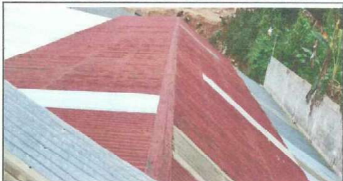
Foto1: Modulo de 3 aulas y corredor, Cambio lamina acanalada a lamina troquelada aluzinc calibre 26, Arriba
