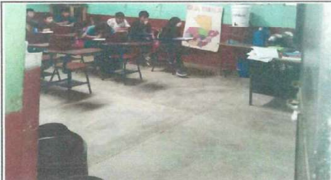
Foto1: Sustrucion de piso alisado a piso ceramico, Aula 1, Interno
