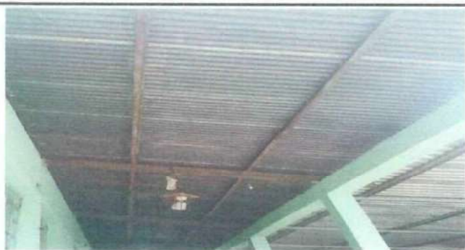
Foto 3: Mantenimiento estructura existente de metal, Corredor, Exterior
