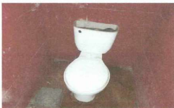
Foto 3: Sustitucion sanitario 2, Interno
