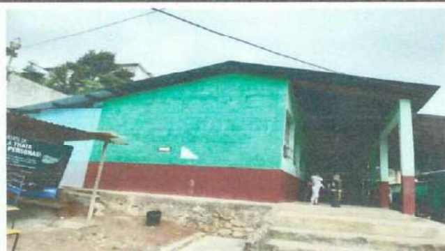
Foto1: Pintura interior y exterior modulo 3 aulas, direccion y corredor, Exterior
