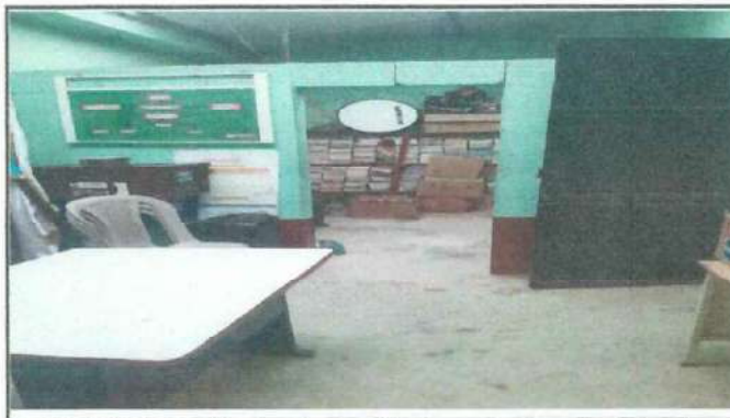
Foto 4: Aula 1, Sustrucion de piso alisado a piso ceramico, Direccion, Interno
