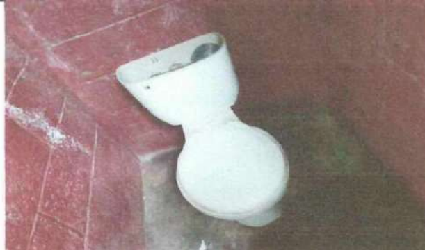
Foto 2: Sustitucion Sanitario 1, Interno
