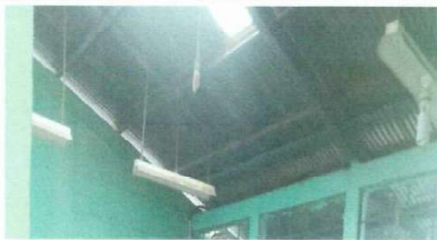
Foto 2: Mantenimiento estructura existente de metal, Aula 1, Interno
