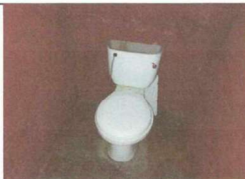
Foto 4: sustitucion sanitario 3, Interno
